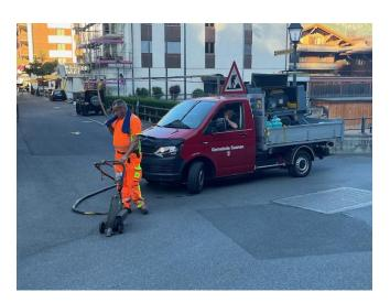
Um die Fahrbahnen vor Frostschäden zu schützen, werden die Risse vergossen
