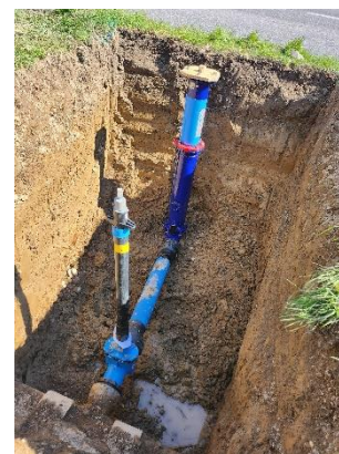
Setzen von neuem Unterteil
