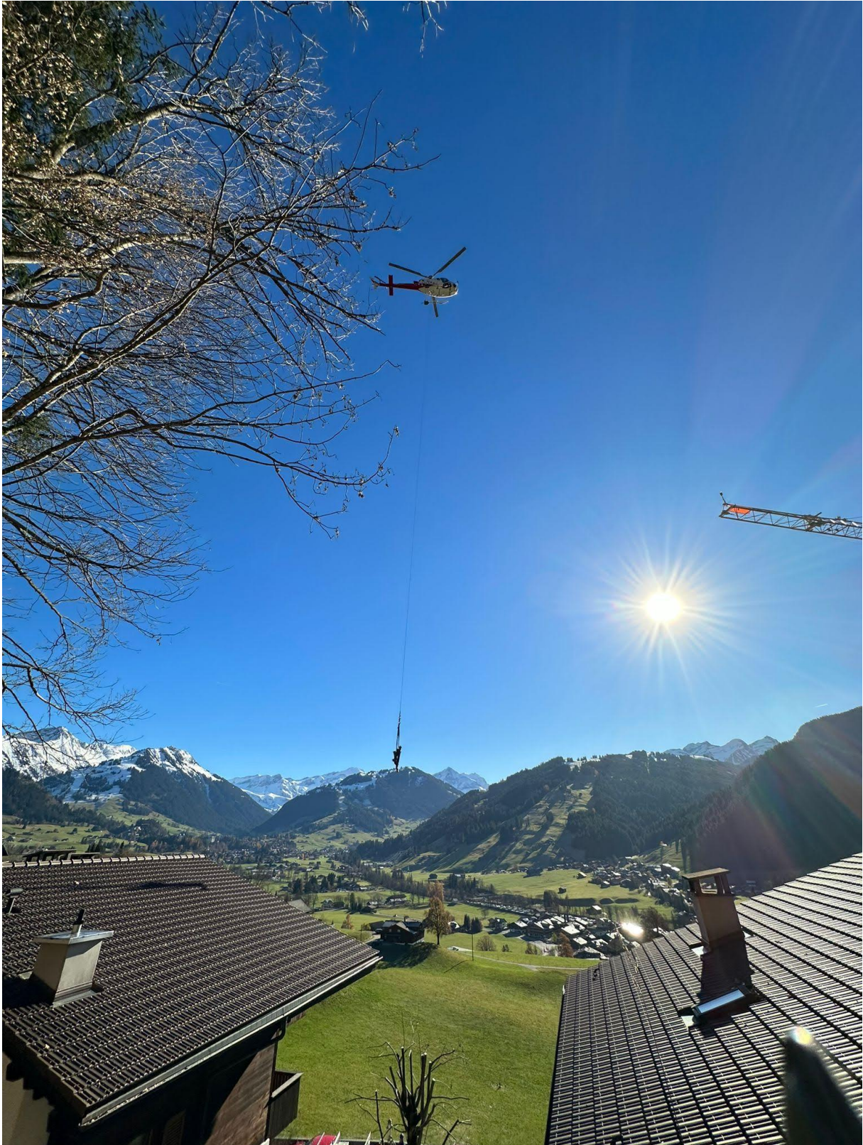
Unterhaltsarbeiten und Ersatz des bestehenden Hydranten Crestalta aufgrund Umgebungsarbeiten der Chalets
